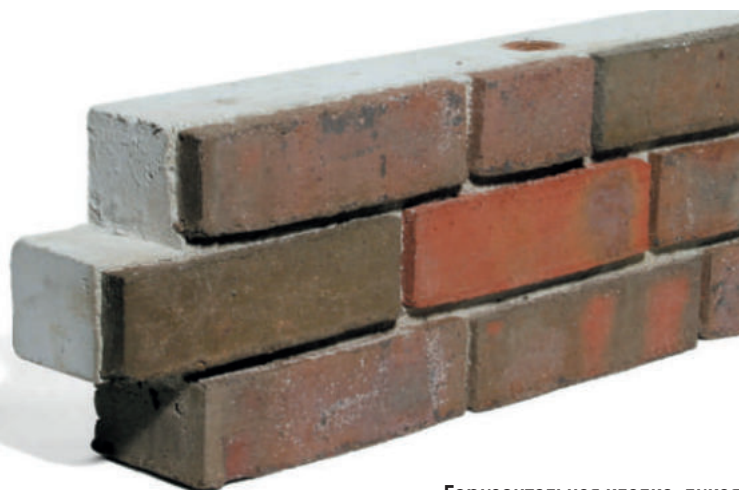
Горизонтальная кладка, дикая перевязка
