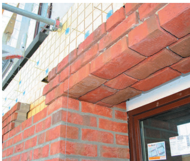
Горизонтальная кладка с прямой опорой, в данном случае с большим откосом дверного проема.
